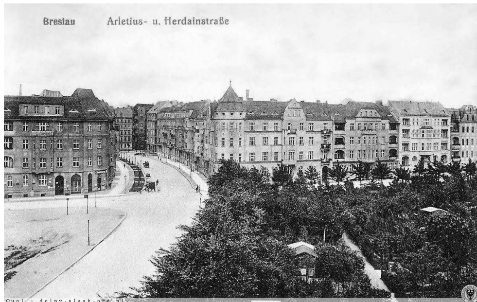
Ulica Dawida i Gajowa, widok z dawnego Technikum Kolejowego.
